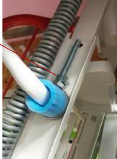
előkészített állapot: acél menetes száraz beillesztése, tömítőgyűrű felragasztása
