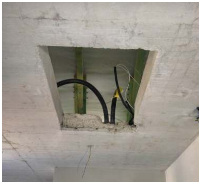
kész fogadószerkezet: kirekesztés monolit vasbeton födémen
