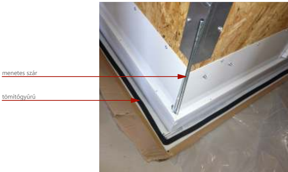
előkészített állapot: acél menetes szárok beillesztése, tömítőgyűrű felragasztása
